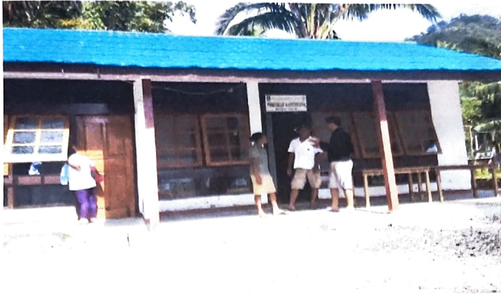
e. Polindes Kemtumelena Kondisi bangunan : Baik
